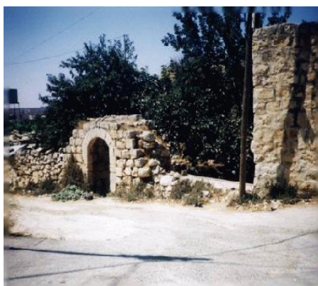
صورة رقم (8) بناء قديم
